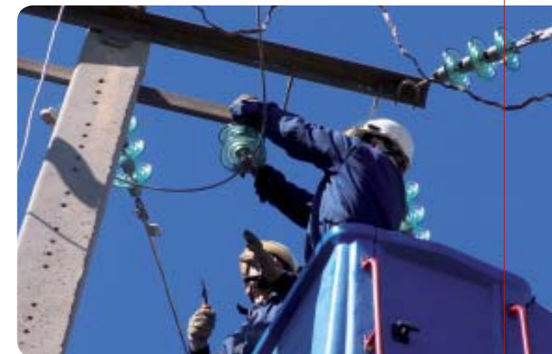
Intervention de maintenance sur un réseau HTA
