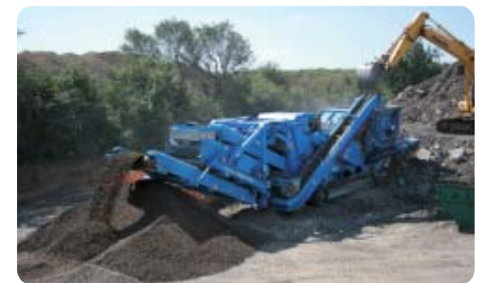
Recyclage des remblais
