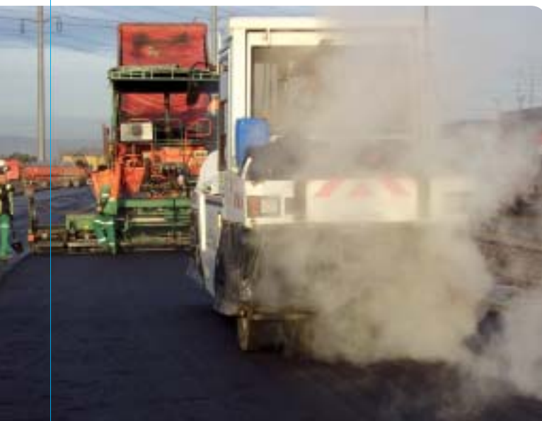
Réfection totale d'une voie après travaux
